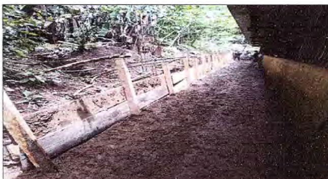
Foto 3: Vista del trabajo del muro contención.
