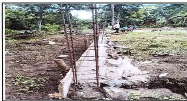
Foto 5: Vista del trabajo en proceso de circulación.
