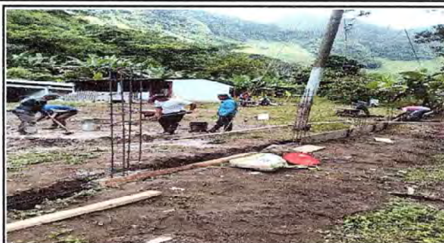
Foto 2: Colocación de columnas de circulación.
