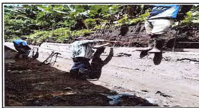
Foto 6: Vista del muro contención en proceso.
