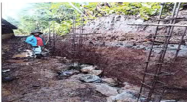
Foto 4: Vista de colocación de columnas del muro contención.
